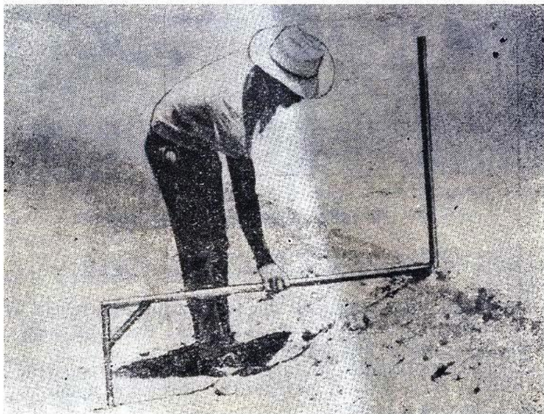
Рис. 14. Прибор для контроля за планировкой земель
