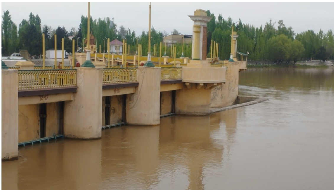
Верхний бьеф Куйганьярского гидроузла
