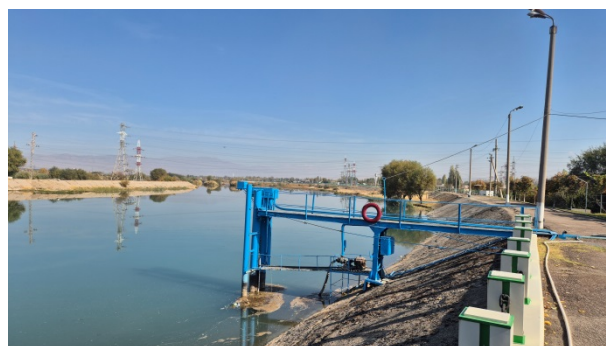
Гидропост на верхнем бьефе ВЧВУ
