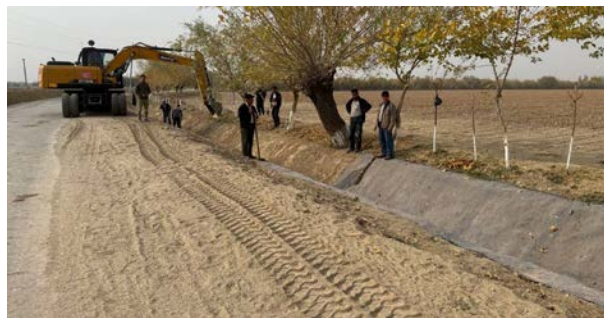
Укладка бентомата на внутрихозяйственной оросительной сети
